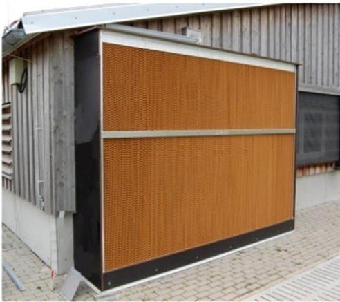
Abbildung 7/8: (links) Kühlpad am zentralen Lufteintritt; (rechts) Detailaufnahme der Wabenstruktur des Kühlpads über die das Wasser fließt.
