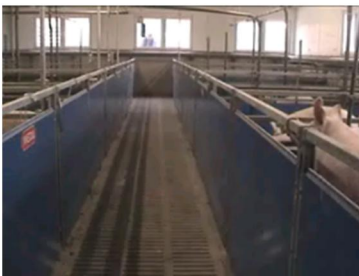
Abbildung 1-4: Zuluftweg der Unterflurzuluft: Abb. oben: Lufteinlass im Winter; Abb. Mitte: Unterflurkanal; Abb. I. unten: Lufteinlass in das Abteil durch Spalten des Zentralgangs; Abb.II .unten: Nebelprobe im Unterflurzuluftabteil im Winter
