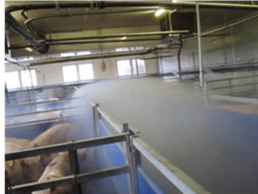
Abbildung 1-4: Zuluftweg der Unterflurzuluft: Abb. oben: Lufteinlass im Winter; Abb. Mitte: Unterflurkanal; Abb. I. unten: Lufteinlass in das Abteil durch Spalten des Zentralgangs; Abb.II .unten: Nebelprobe im Unterflurzuluftabteil im Winter
