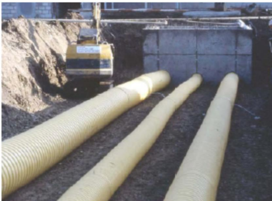
Abbildung 9/10: (links) Einbau eines Rippenrohrtauschers; (rechts) Schutzgitter + Abdeckung um die Zuluftrippenrohre gegen Eintritt von Schädner
