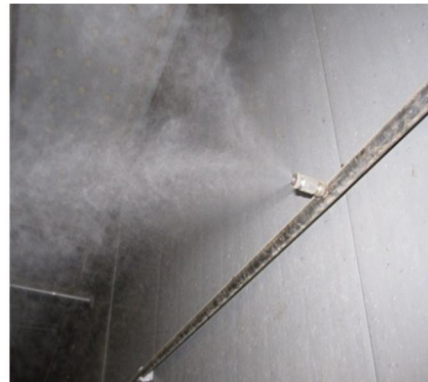
Abbildung 5/6: (links) Hochdruckbefeuchtungsanlage mit dazu gehörenden Filteranlagen; (rechts) Vernebelung des Wassers im Abteil
