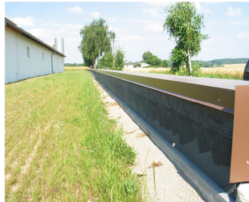
Abbildung 9/10: (links) Einbau eines Rippenrohrtauschers; (rechts) Schutzgitter + Abdeckung um die Zuluftrippenrohre gegen Eintritt von Schädner
